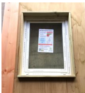
Photo vue extérieur sans bardage
